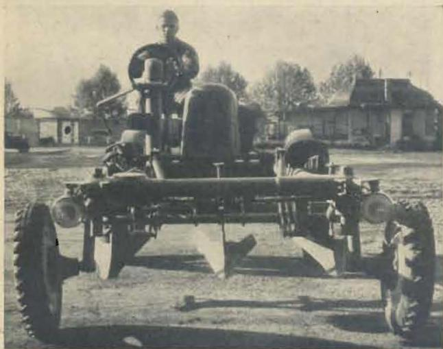
Bild 1. Der neue Lanz-Motor-Geräteträger 12 PS mit angebautes Häufelgerät
