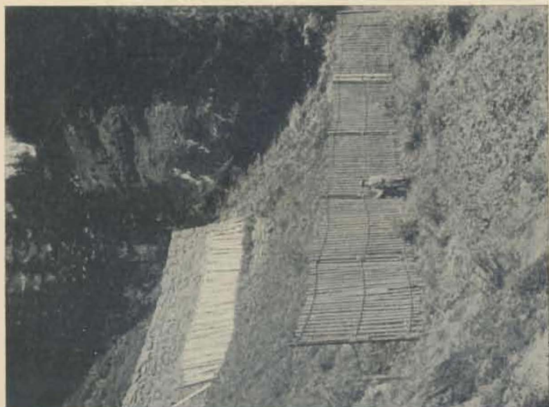
Fig. 17. Schneerücken aus alten Eisenbahnschienen, verbunden mit Drahtseilen, an denen Satten befestigt sind, im Veneistertobel, 1600 m ü. M., am Aarberg
