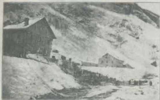
Abb. 4 Durch die Gneinlawine am 29. Februar 1908 zerstörtes Restaurant in Goppenstein (Blick gegen das Tunnelportal, welches durch die Installationsbauten im Hintergrunde verdeckt ist)
