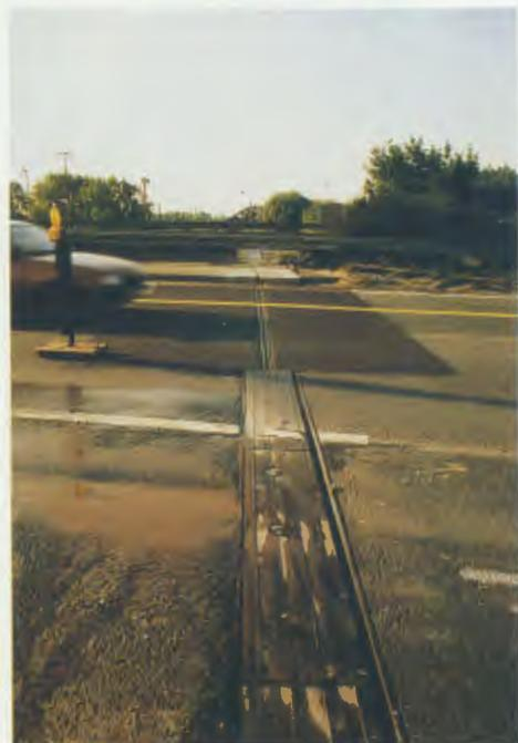
Zunehmend werden die vorhandenen wasserdurchlässigen Fahrbahnübergangskonstruktionen durch neue, wasserdichte ersetzt. Auf stark frequentierten Autobahnen können diese Arbeiten wegen der Verkehrsbehinderungen nur an Wochenenden ausgeführt werden. Von Freitagabend bis Montagmorgen wechselt unser Personal in Tag- und Nacht zahlreiche Konstruktionen aus.
