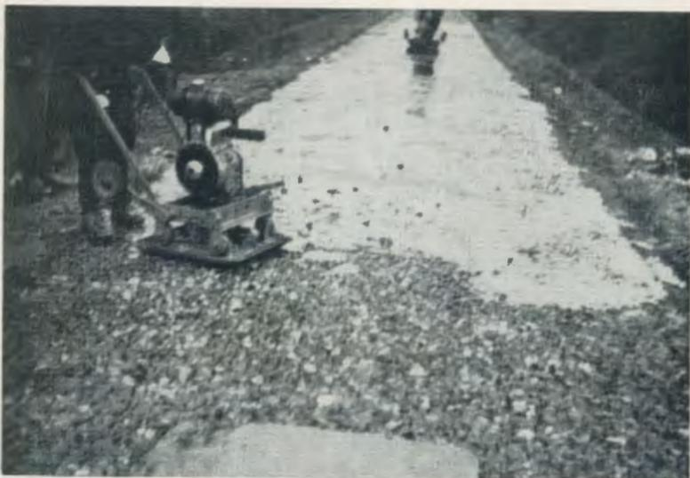
Abb. 107: Einrütteln der Schlämme mit Vibrierplatte – 1. Arbeitsgang
