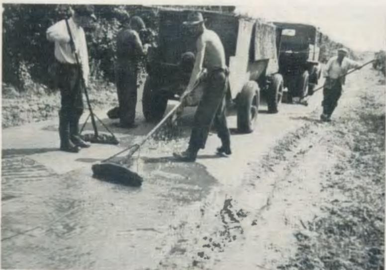
Abb. 108: Aufbringen der Schlämme mit Ausfuhrwagen und Verteilen von Hand mit Schwabbern
