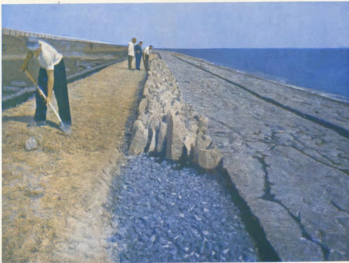
Abb. 133 Seedeichsicherung im Westen der Insel Pellworm. Rückwärtig der bestehenden Hinterpflasterung wird eine Übersturzicherung mit Rauhstreifen angeordnet. Den hinteren Abschluß der Asphalteingußdecke bilden dicht versetzte Basaltsäulen von 40 cm Höhe. — Links im Hintergrund ist das Maß der Deicherhöhung an dem nicht begrüntem Teil der Böschung zu erkennen.
