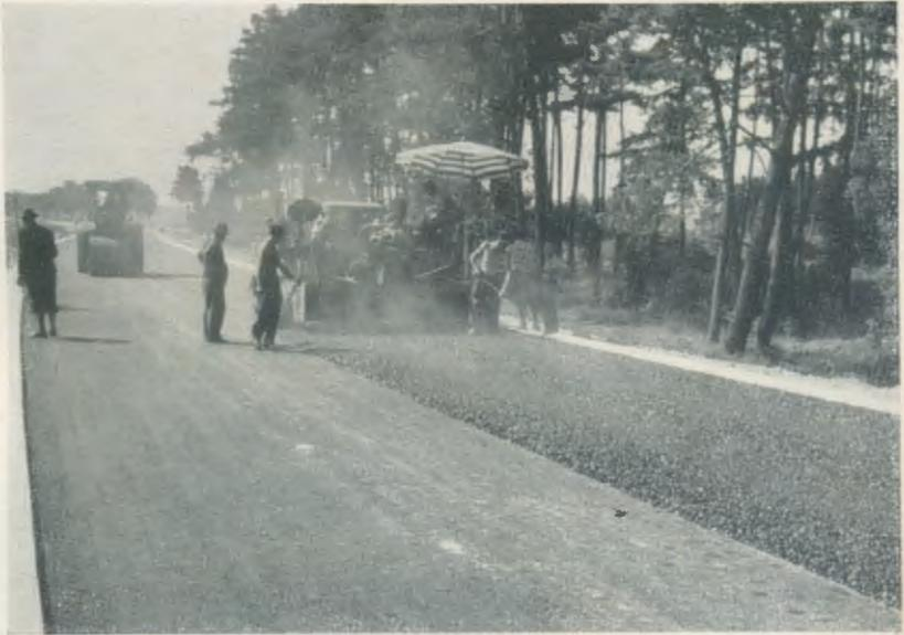
Abb. 221 Bundesstraße 12 bei Schwilting, Bituminöser Unterbau, Einbau der oberen Lage mit Fertiger Vögele Super 100. Verdichtung mit 11-to-Walzen
