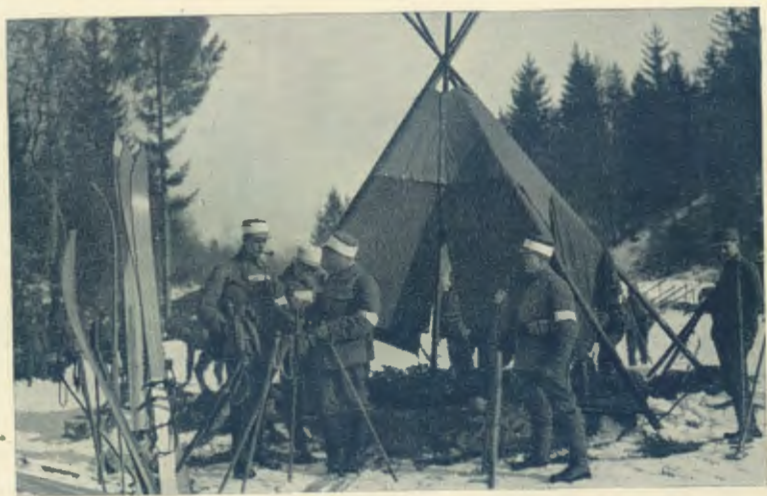
Heißbares Spitzzelt während des Abbruches. C. F. S. phot.
