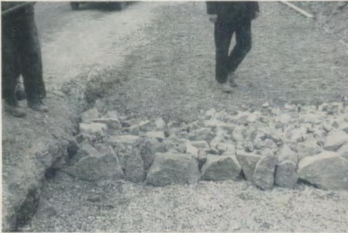
*Abbildung 1: Packlage mit ungleichförmigen Packlagesteinen verschiedenen großer Fußflächen und deshalb ungleichmäßiger Druckverteilung auf den Untergrund.*
