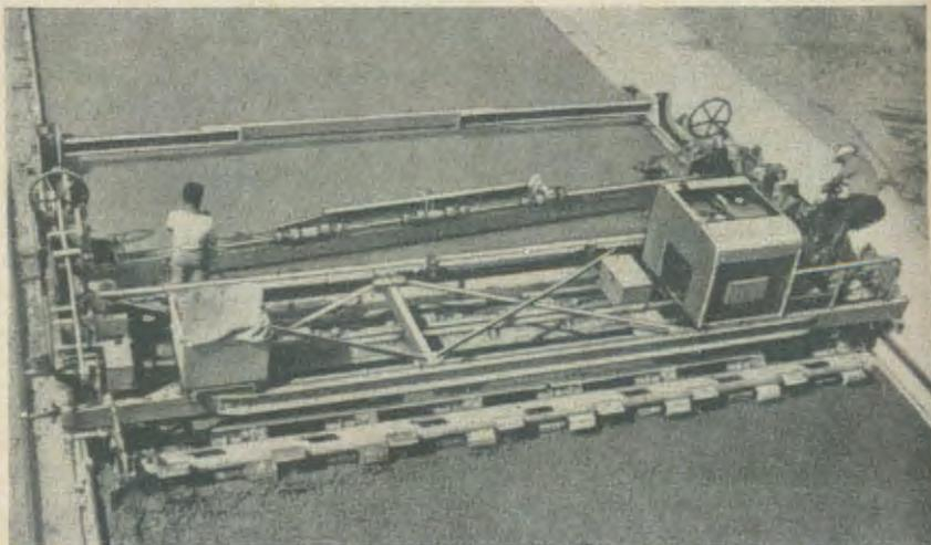
Bild 4/10. Betonfertiger mit angehängtem Nivellierglätter, Arbeitsbreite 7,50 m
