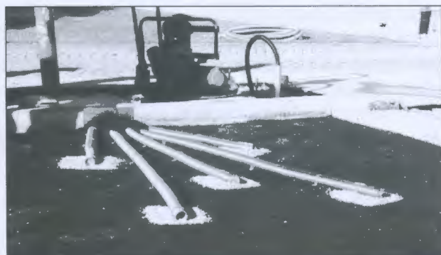
Bild 11: Einbau der Kabelkanäle auf der Tragschicht
