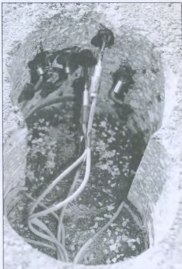
Bild 14: Einbau der Thermoelemente von Pt-100 im Bohrloch
