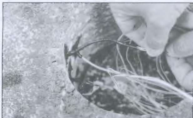
Bild 13: Einschieben eines Pt-100 für die Fahrbahnoberflächentemperatur mit Bitumenmörtel in eine Bohrung
