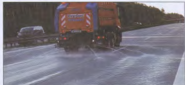
Bild 12: Schmidt – Sprühmaschine „Straliq“ mit einer eingestellten Sprühdichte von 40 g/m 2 und Sprühbreite von 11,25 m
