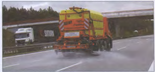
Bild 11: Küpper-Weisser – Sprühmaschine „Full Wet“ mit einer eingestellten Sprühdichte von 20 g/m 2 und Sprühbreite von 7,50 m
