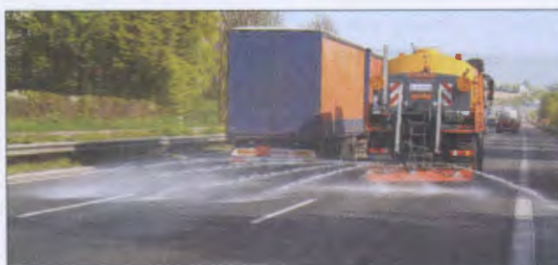
Bild 10: Epoke – Sprühmaschine mit einer eingestellten Sprühdichte von 20 ml/m 2 und einer Sprühbreite von 11,00 m
